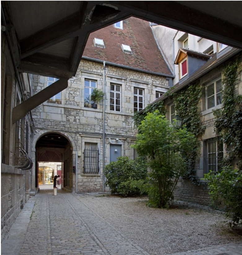
Logis principal : aile sur rue, façade postérieure.
