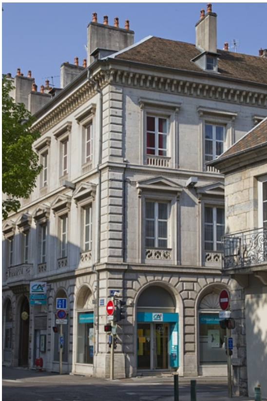
Logis principal : vue de l'angle sur rue.
