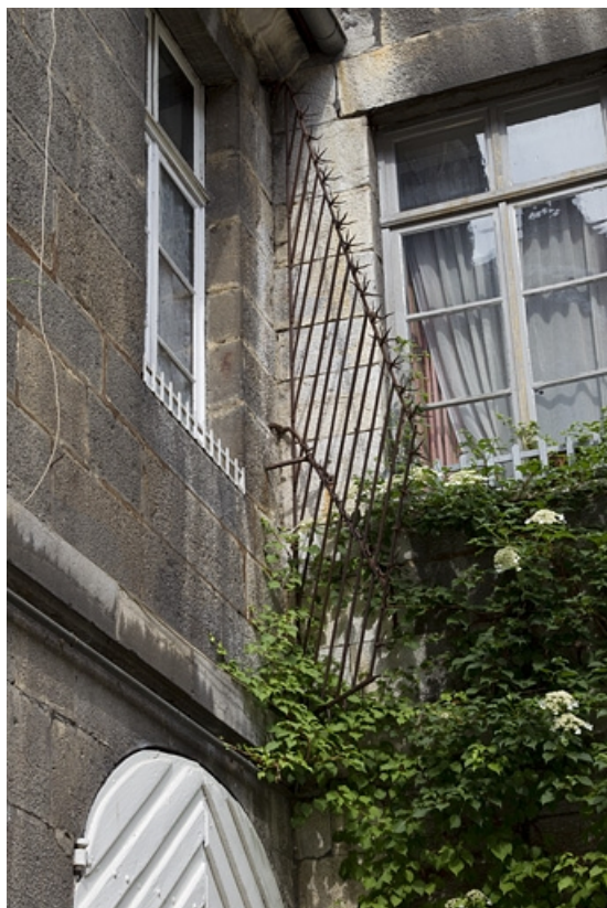
Cour : détail d'une grille de protection.
