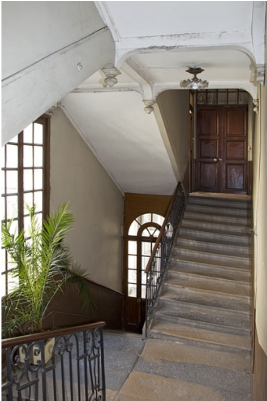
Vue d'ensemble de l'intérieur de l'escalier.
