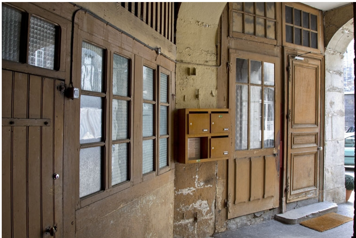
Ecurie : vue de la façade extérieure.
