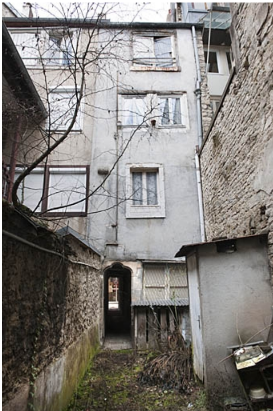
Logis principal : façade postérieure, de face.
