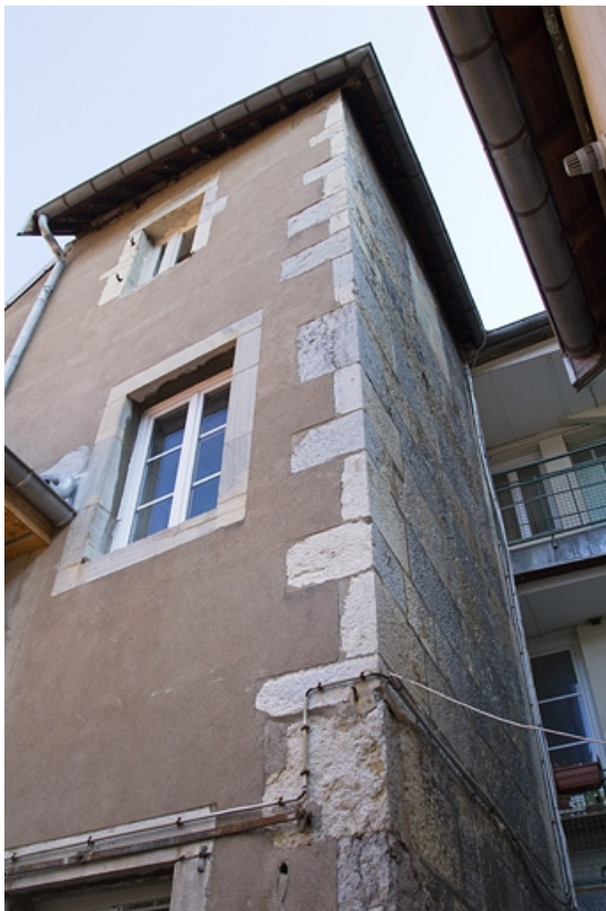
Logis principal : détail de l'aile sur cour.
