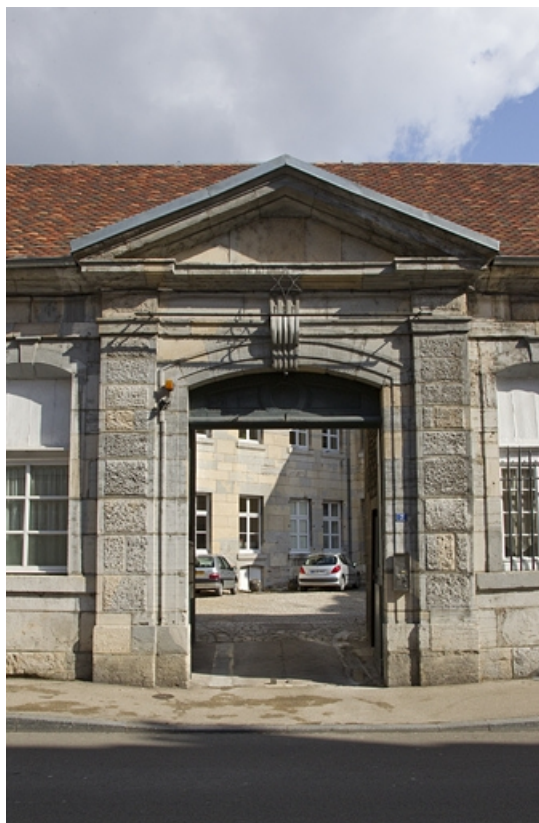
Vue du portail dans clôture : de face.
