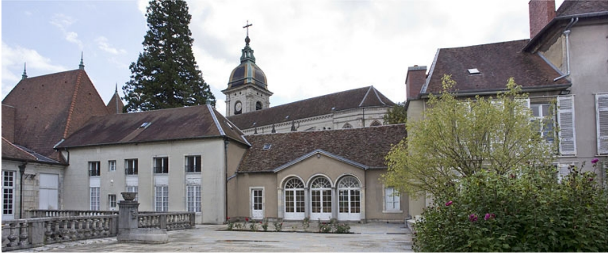
Orangerie : vue d'ensemble éloignée, de face.
