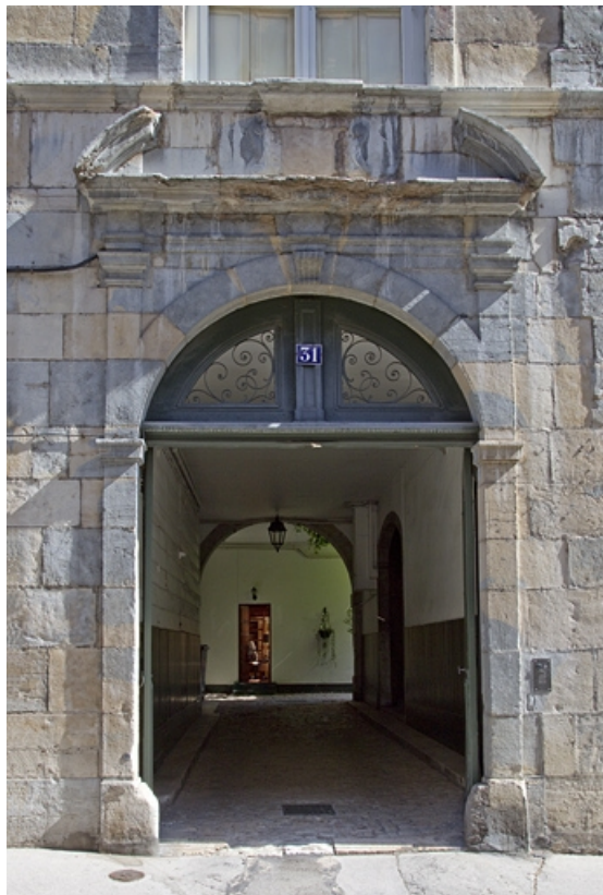
Logis principal : détail du portail d'entrée.
