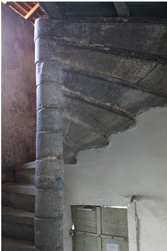
Deuxième logis secondaire : détail d'escalier en vis.
