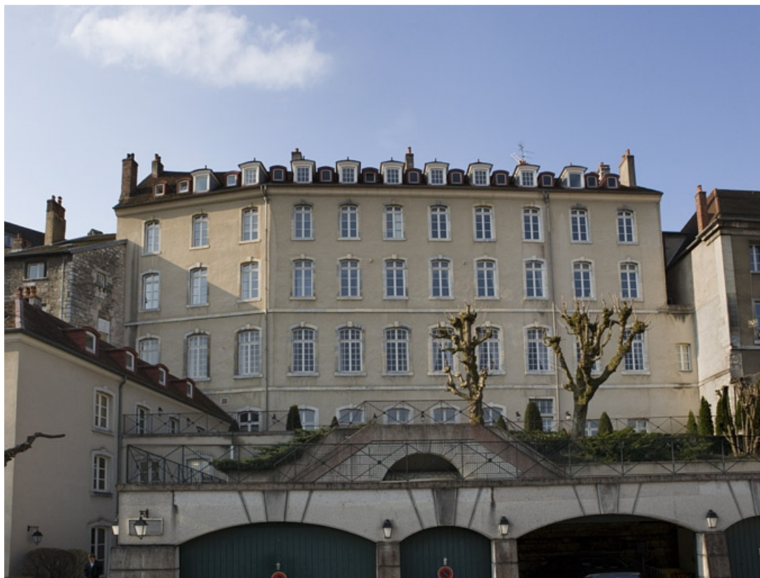
Vue d'ensemble de la façade postérieure.
