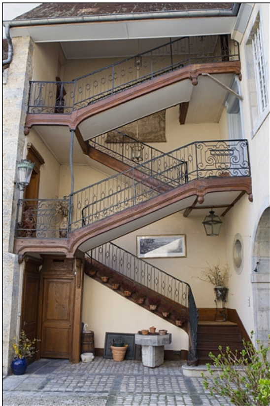
Vue d'ensemble de l'escalier à cage ouverte.
