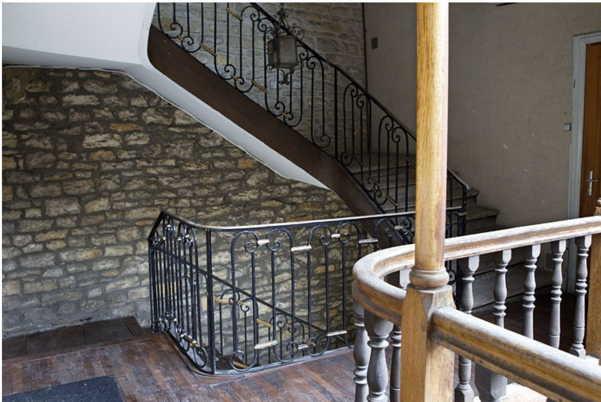
Détail de l'intérieur de l'escalier principal.
