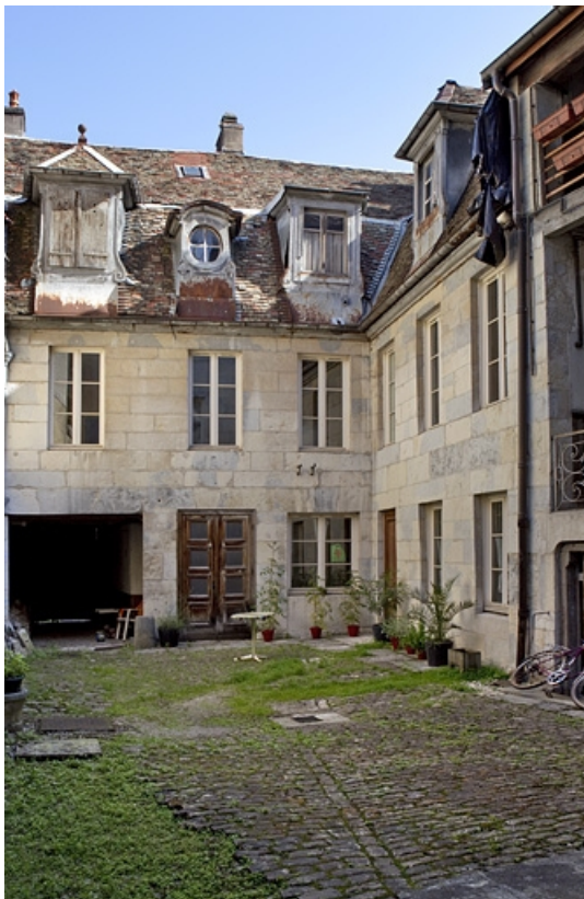
Façade antérieure du premier logis secondaire.
