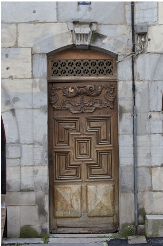
Logis principal : détail de la porte d'entrée.
