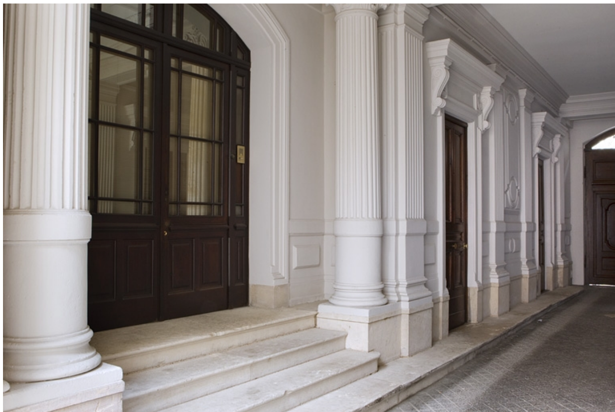
Passage cocher :détail du mur droit.
