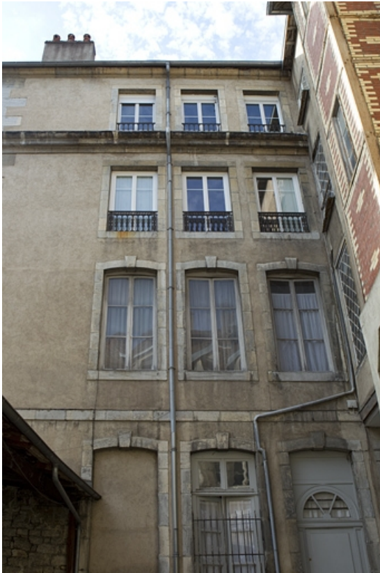
Vue d'ensemble de l'aile gauche sur cour.
