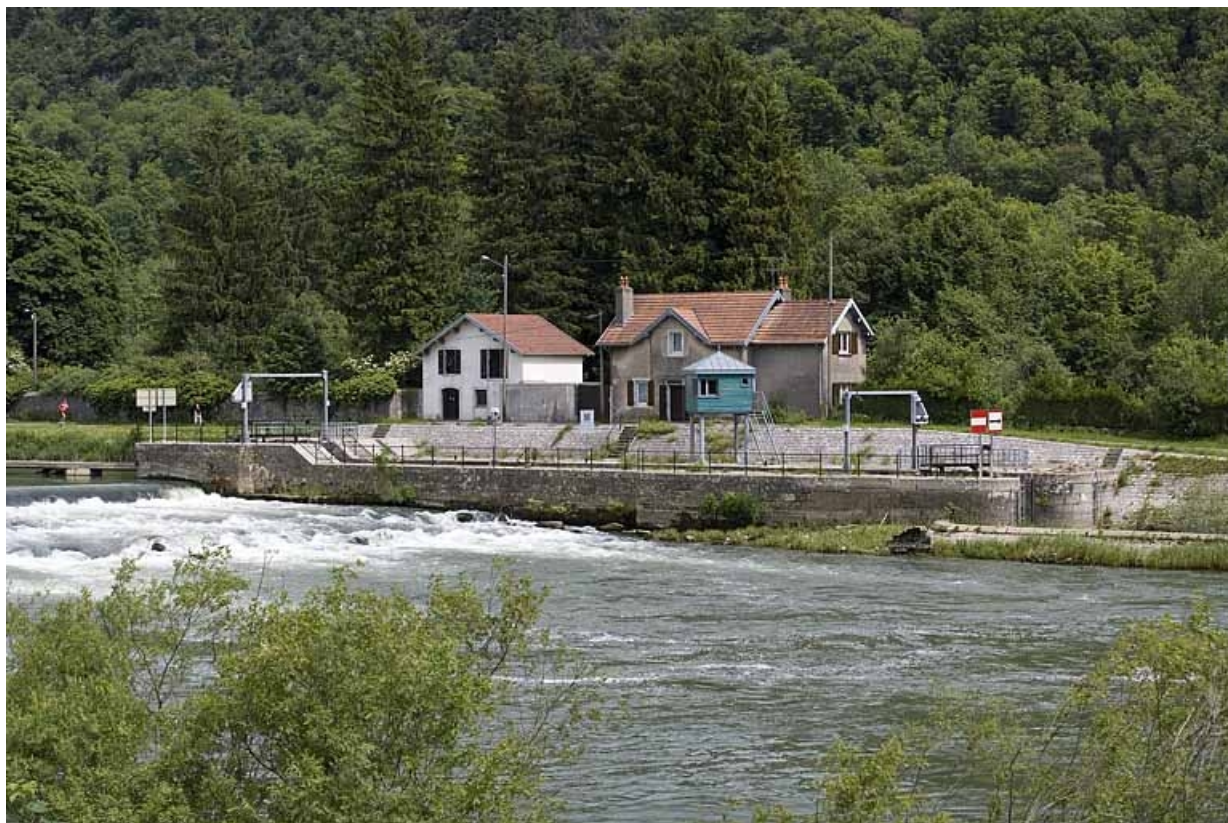
Vue d'ensemble rapprochée, depuis l'aval.
