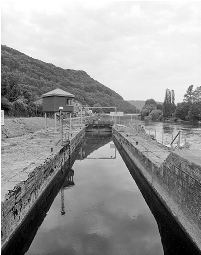
Ecluse et sa porte aval, depuis l'amont.
