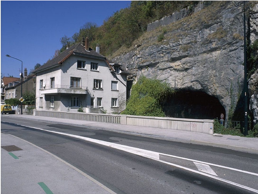
Pont routier et maison d'éclusier.
