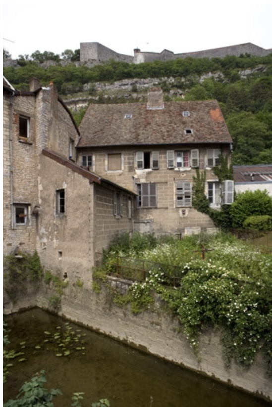
Façade postérieure des logements désaffectés.
