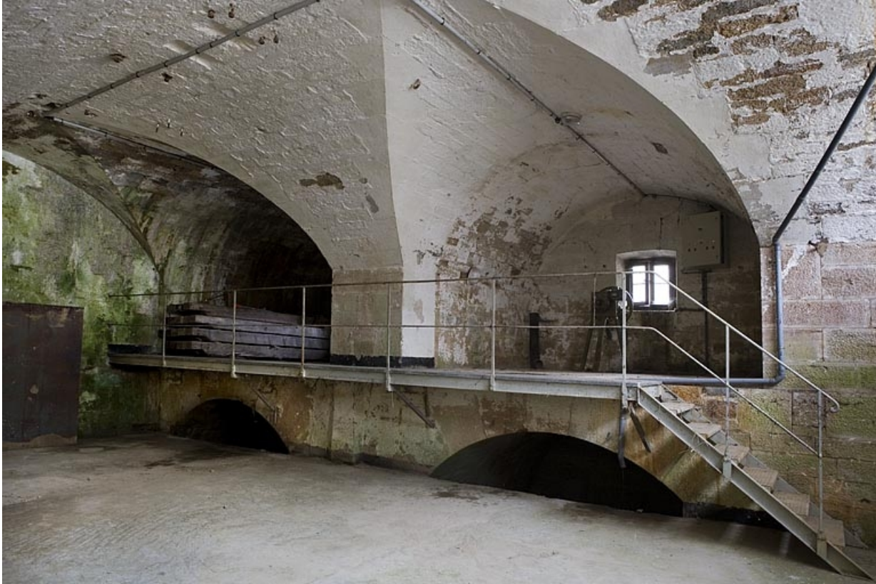
Intérieur de la casemate amont : coursiers voûtés.
