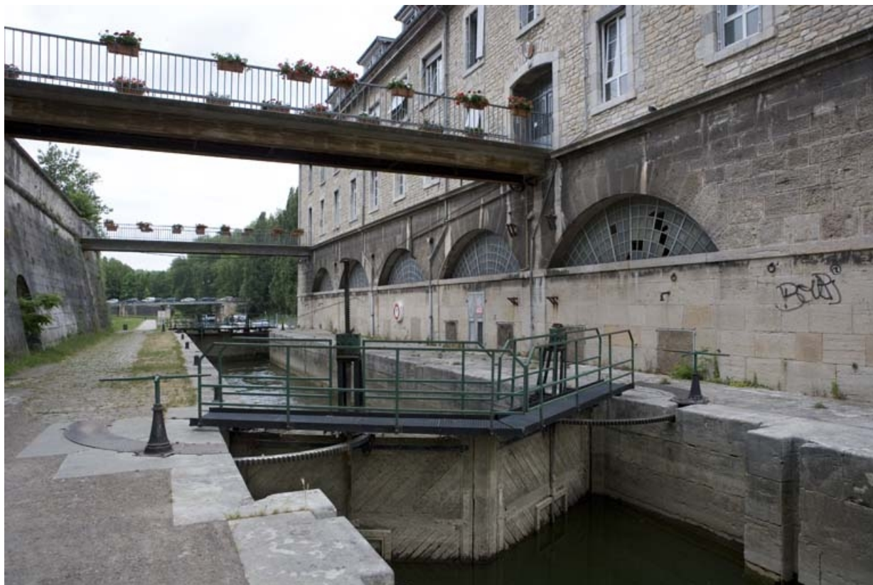
Vue d'ensemble depuis l'amont, côté gauche.
