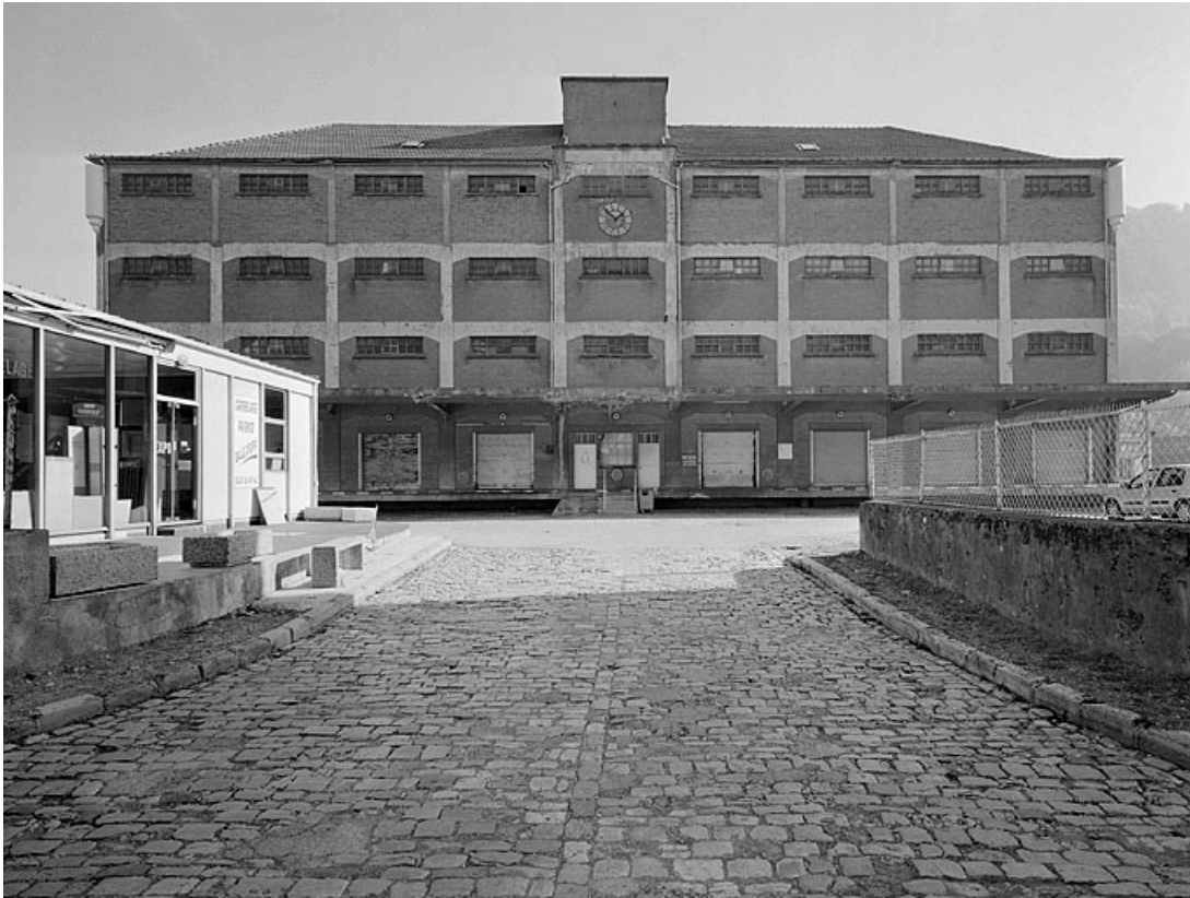
Entrepôt : façade antérieure.
