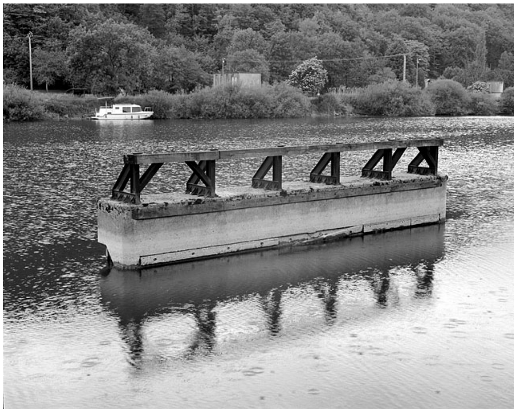
Un des éléments du mur guide.
