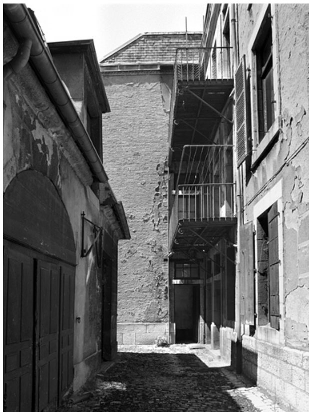
Logis secondaire droit : façade latérale gauche.
