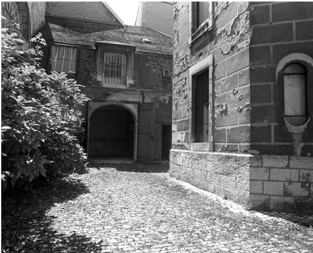
Vue du bâtiment des remises, de face.
