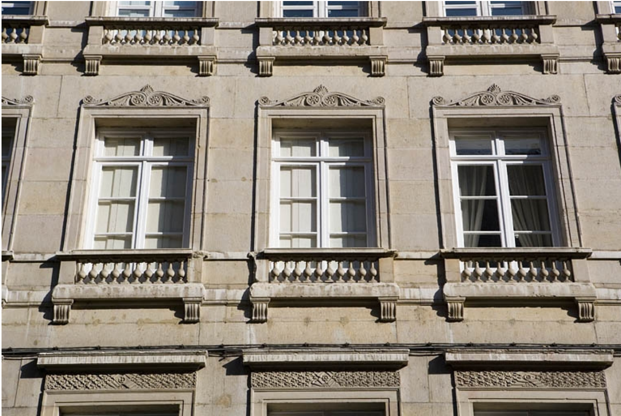
Détail des fenêtres du premier étage.
