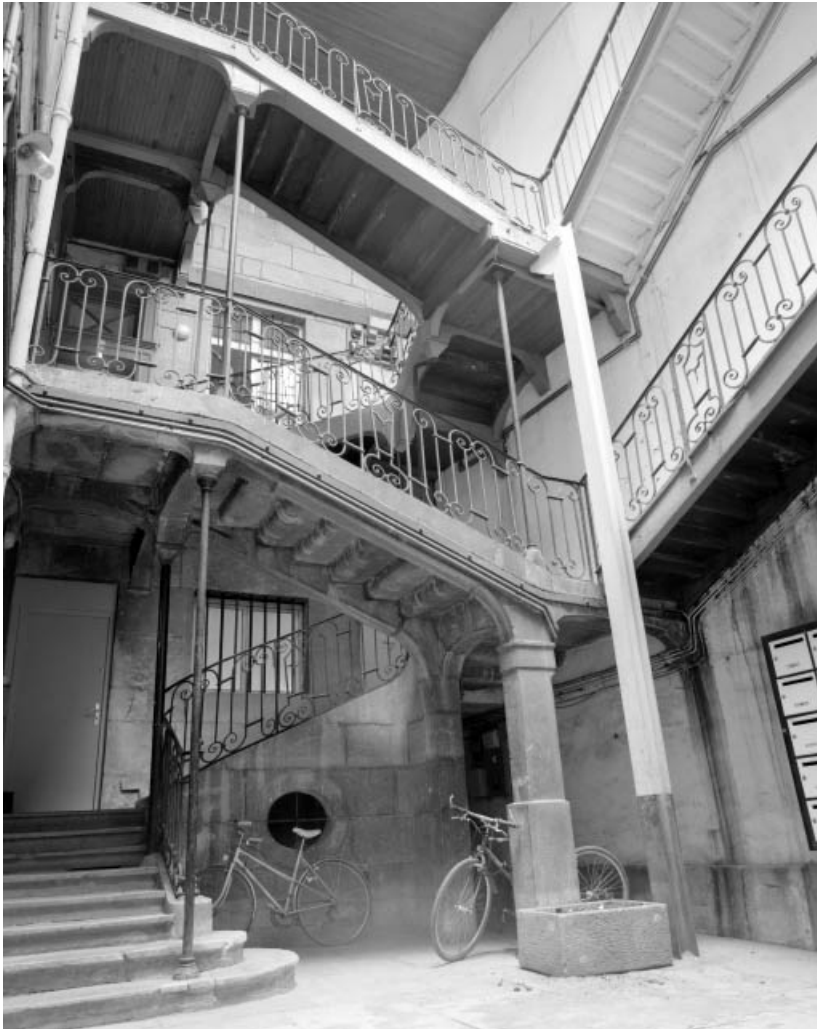
Vue d'ensemble de l'escalier à cage ouverte.
