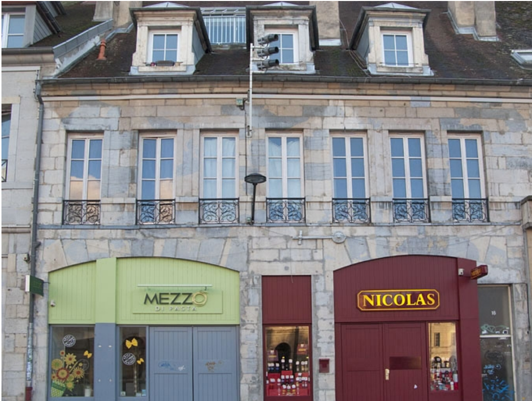
Vue d'ensemble rapprochée de la façade antérieure.
