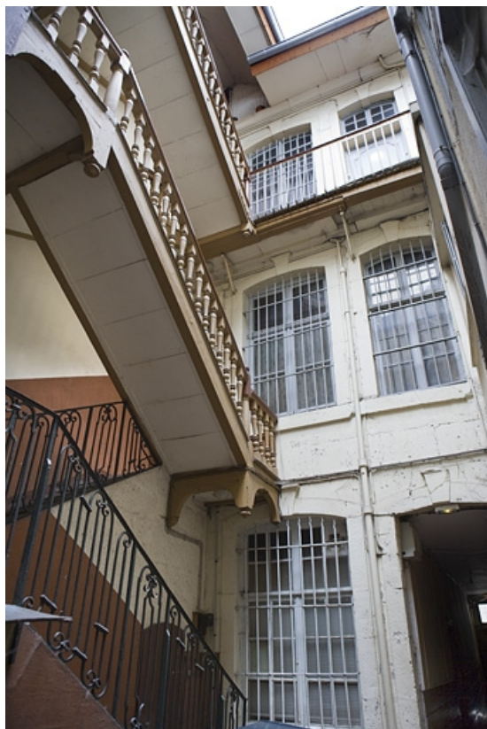
Façade postérieure du logis principal.
