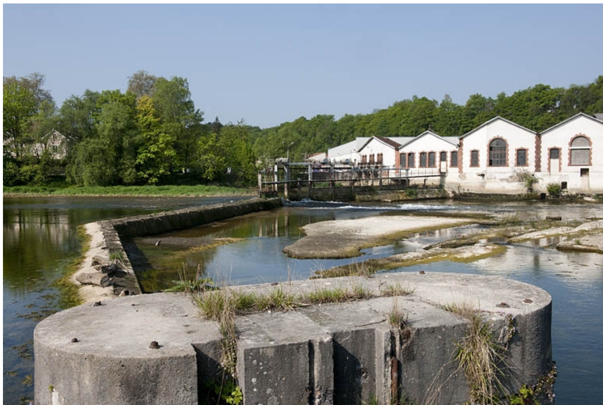
Le barrage depuis la rive droite.
