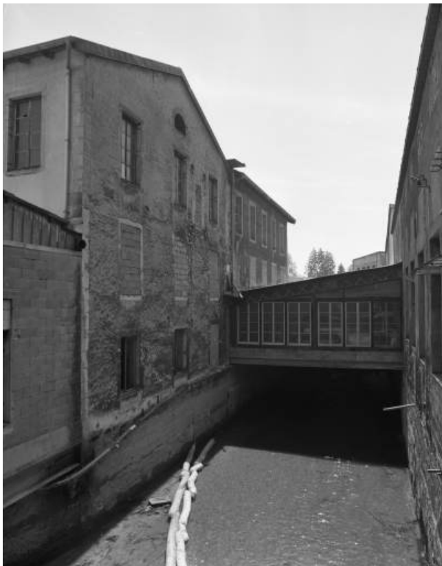
Atelier outillage-entretien mécanique. Façade ouest. 25, Valentigney R.D. 38
