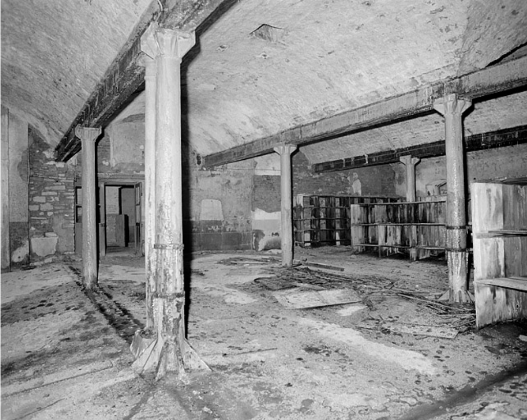
Premier étage, grande salle, côté ouest.
