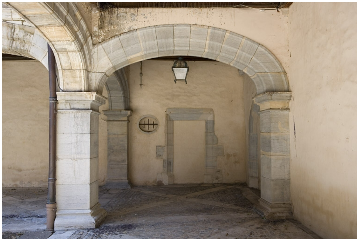
Détail de l'angle ouest du portique.
