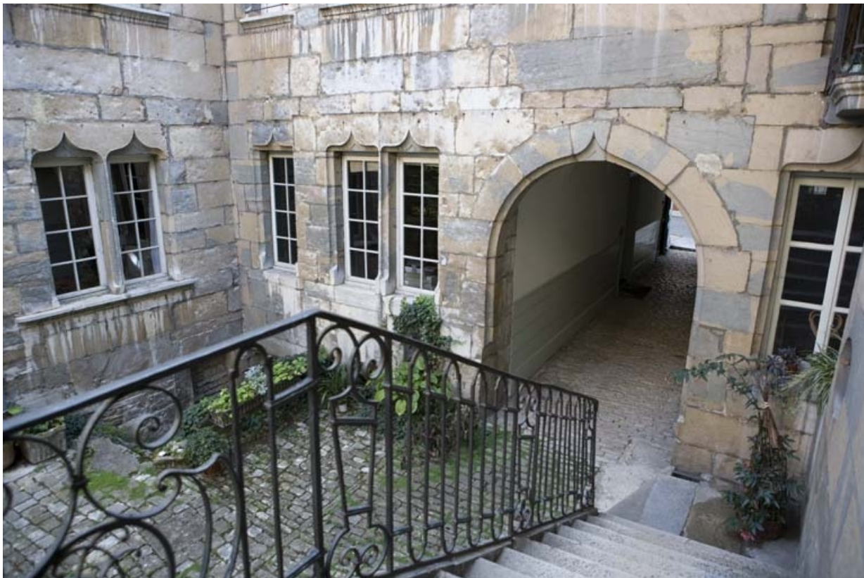
Détail du rez-de-chaussée sur cour depuis l'escalier.
