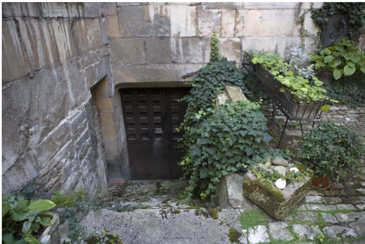
Façade postérieure du logis : entrée de cave.
