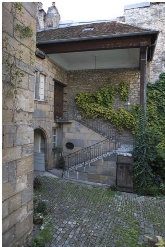
Vue d'ensemble de l'escalier extérieur, de face.
