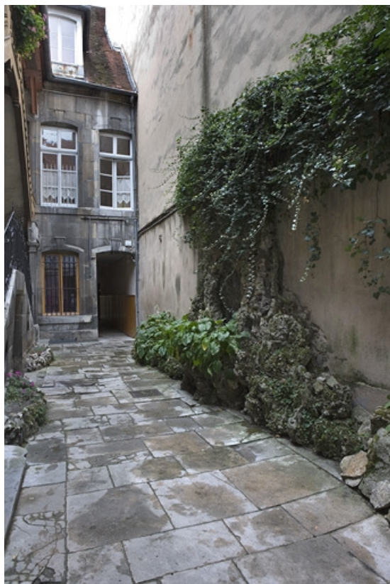
Façade antérieure du logis secondaire sur cour.
