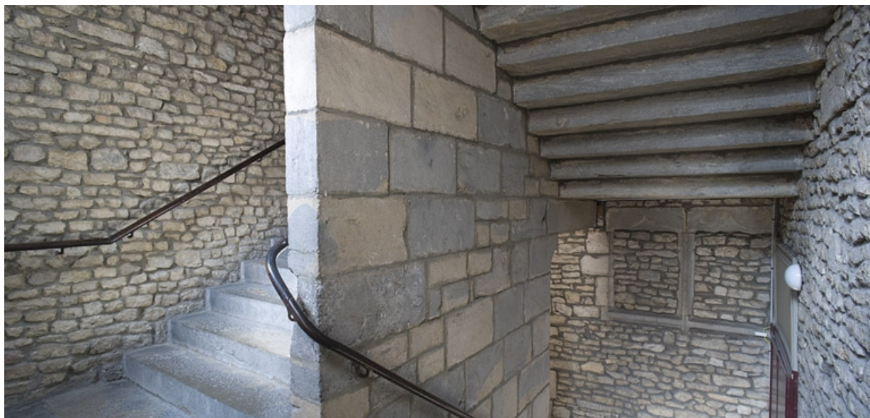
Détail de l'escalier principal en maçonnerie.
