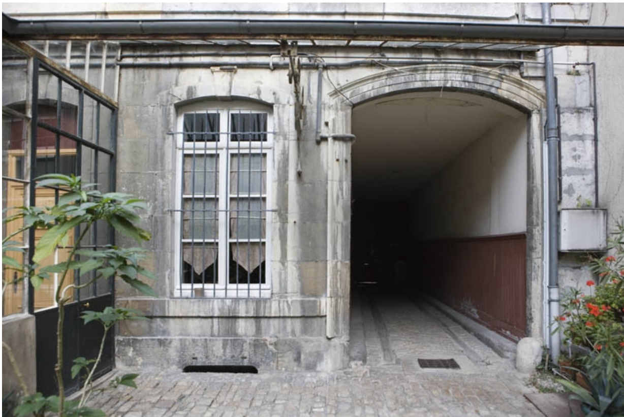
Détail du passage cocher, côté cour.
