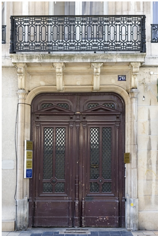
Détail du portail d'entrée sur rue.
