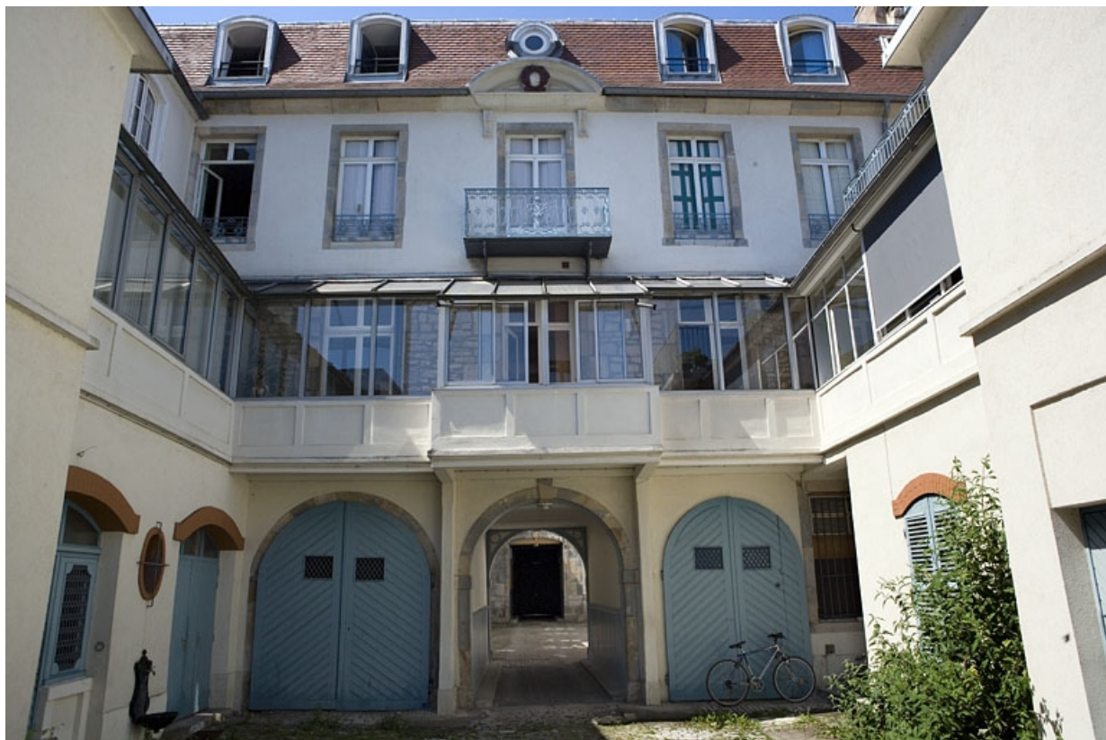
Façade postérieure du logis secondaire, de face.
