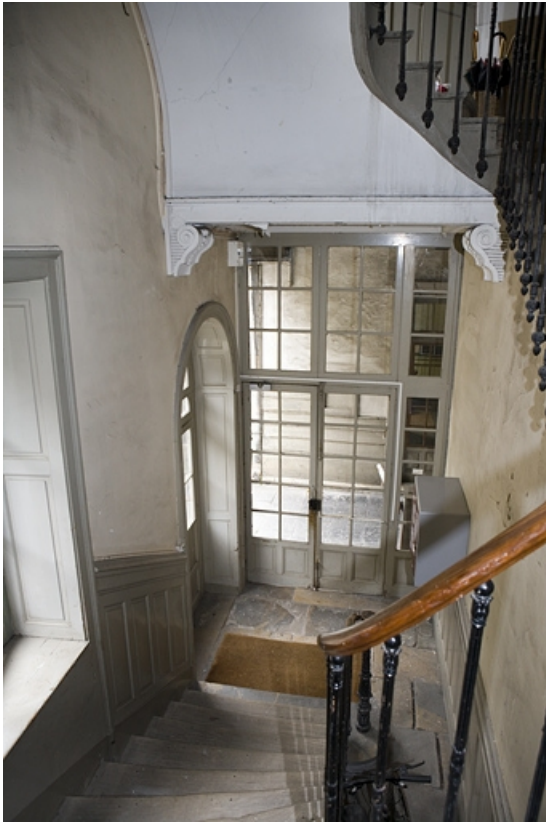
Vue de l'escalier droit.
