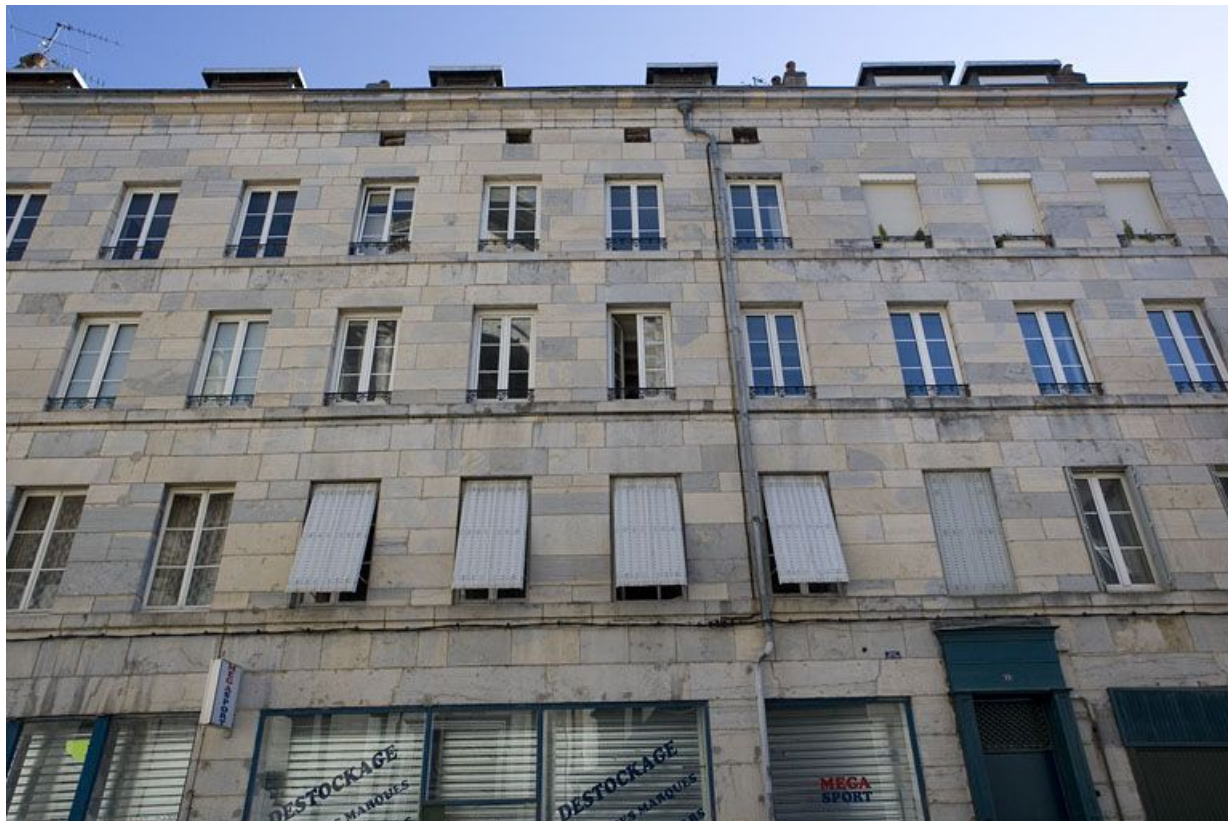
Vue d'ensemble de face depuis la rue.
