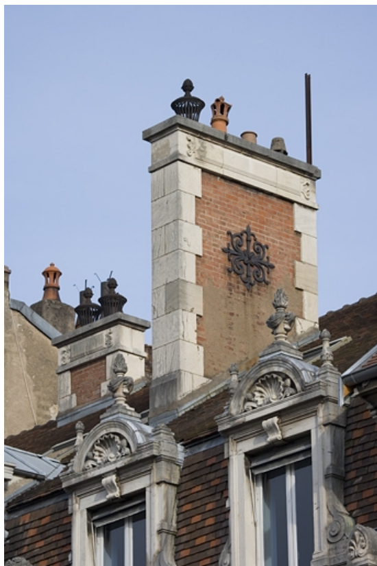
Détail d'une souche de cheminée.
