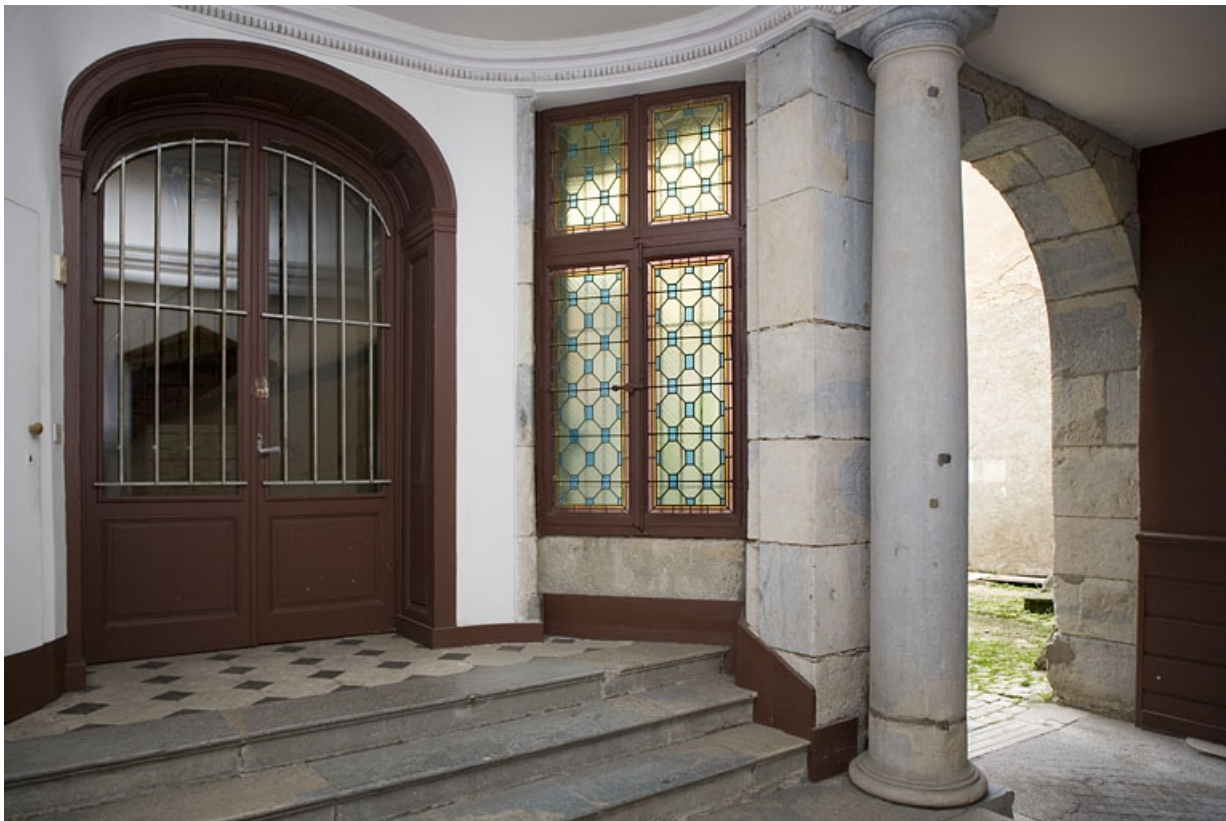
Vue de l'entrée de l'escalier.
