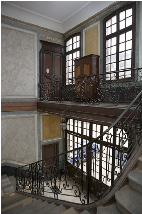
Vue d'ensemble de l'escalier d'honneur.
