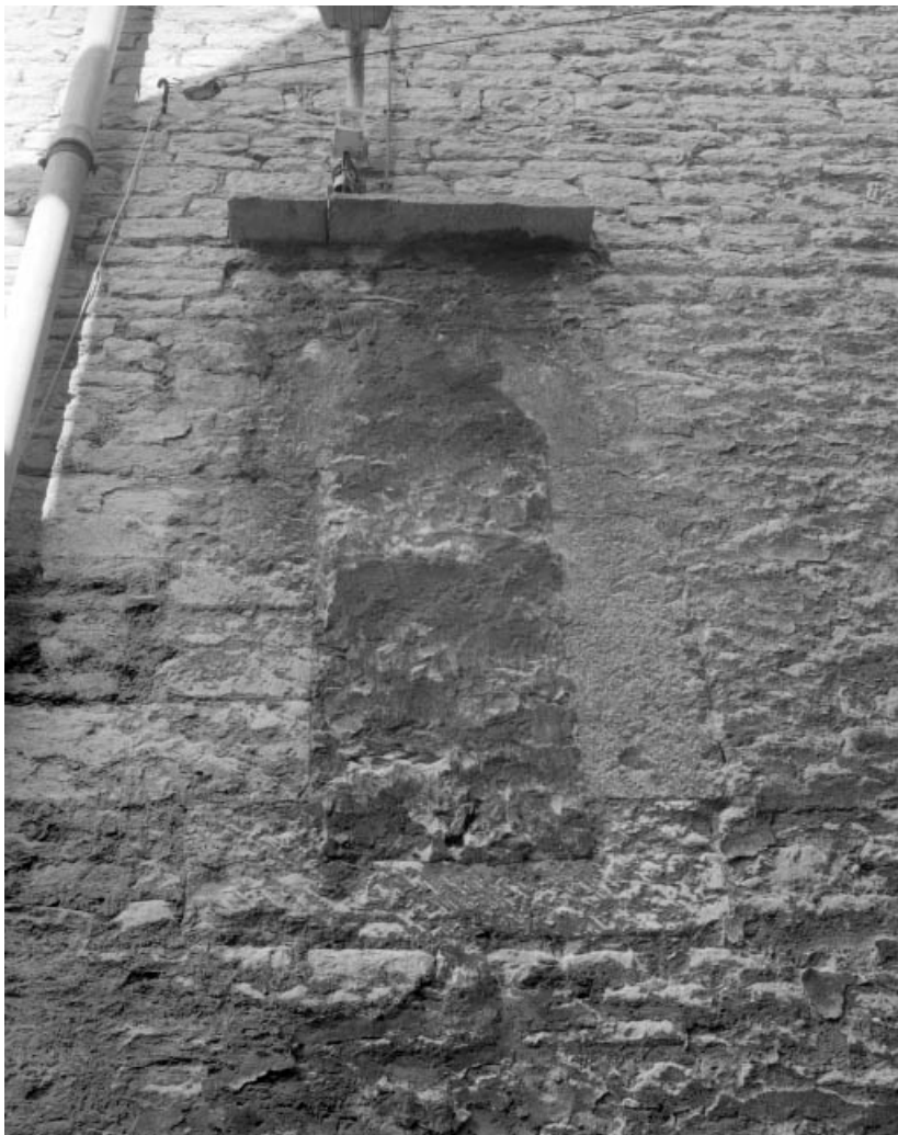
Façade latérale gauche : détail d'une baie murée.
