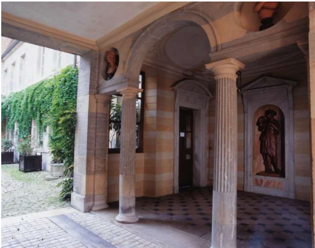
Passage d'entrée : détail de la partie droite.
