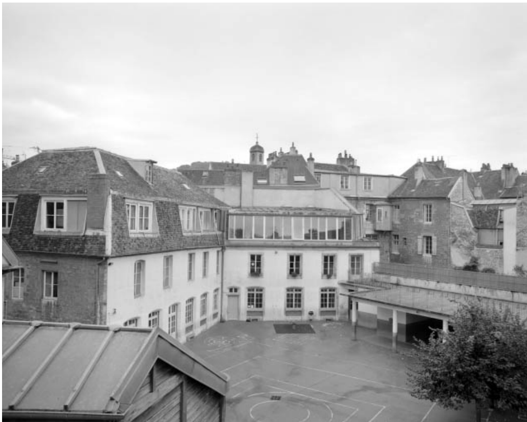
Vue d'ensemble de la deuxième cour.
