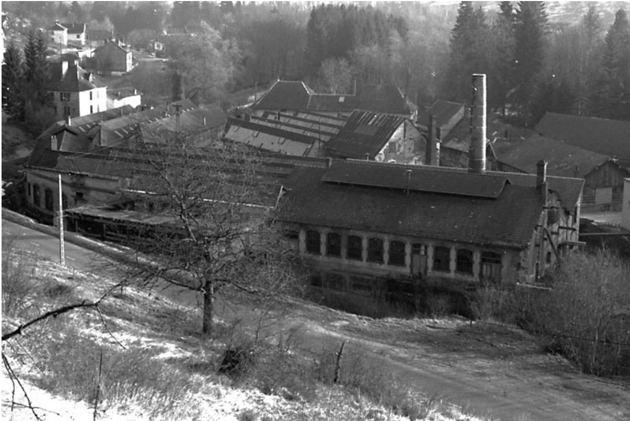
Vue générale de la clouterie d'Hauterive. 25, Vuillafans
