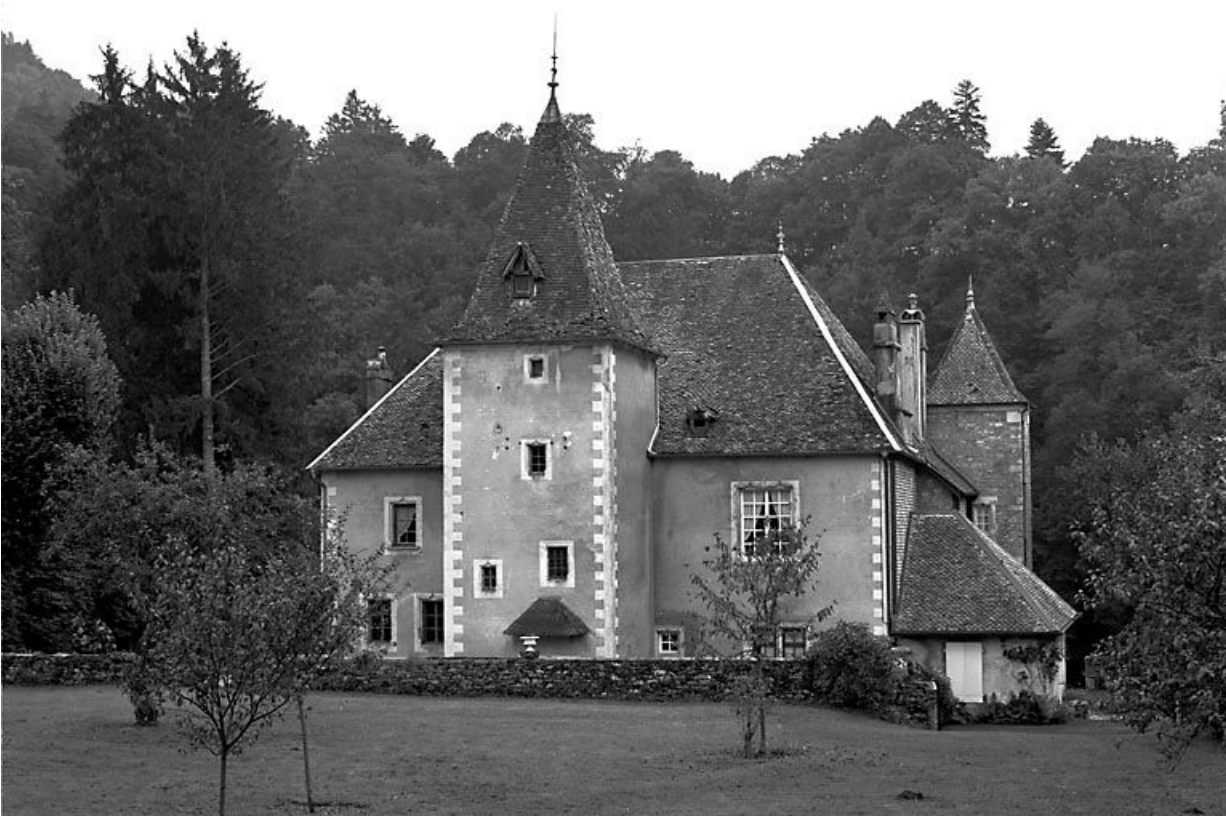
Façade antérieure. 25, Scey-Maisières
