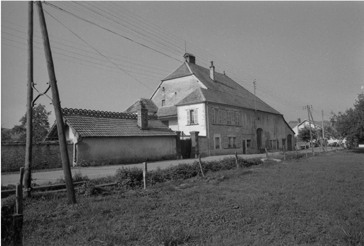
Vue d'ensemble depuis la rue.
