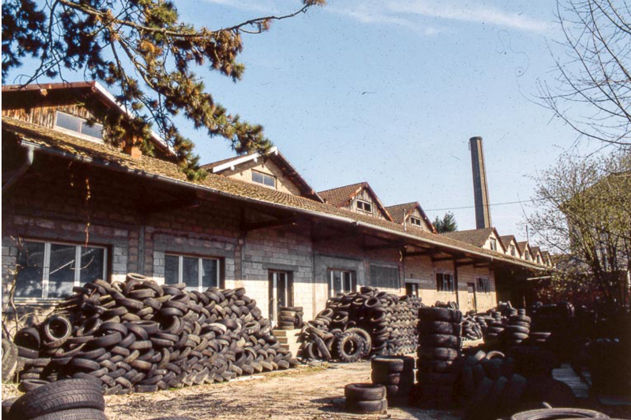
Quai couvert et magasins industriels depuis l'ouest.
